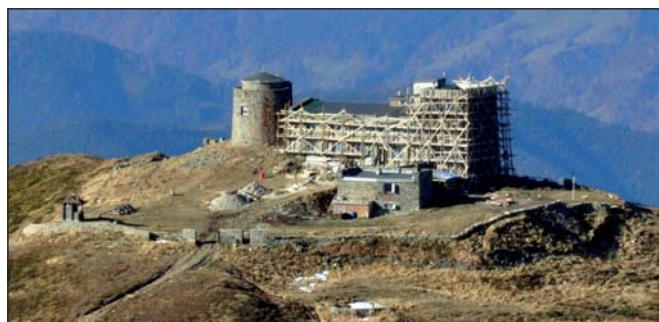
Роботи з відновлення обсерваторії станом на листопад 2020 року. Джерело: Вікіпедія
