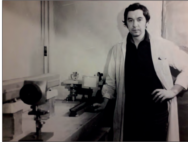
Рис. 1. Володимир Захожай біля спеціально створеної установки Лабейрі (когерентна оптична установка) для пошуку екзопланет методом спекл-інтерферометрії. Астрономічна обсерваторія Харківського державного університету, 1979 р.
