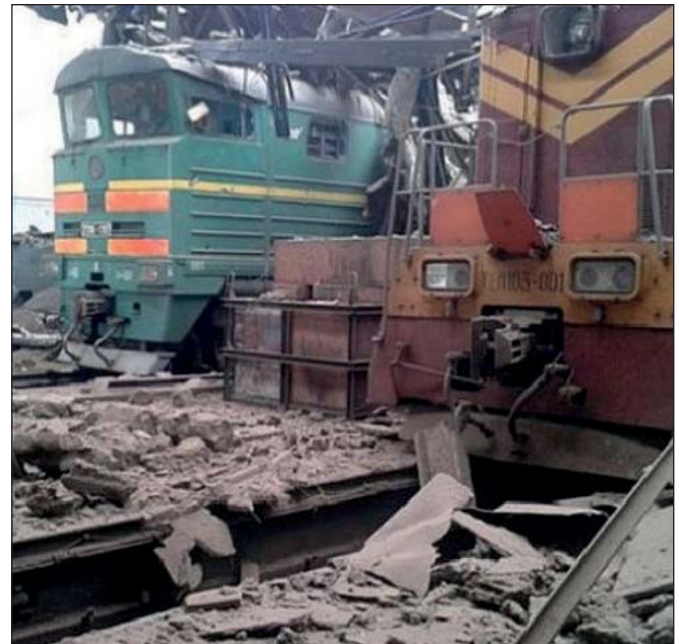
Зруйнований залізничний вузол в Дебальцеве. https://novyny.online.ua/794047/
