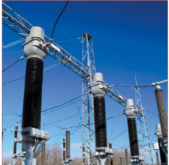
Рис. 3. Каскадний трансформатор напруги 330 кВ
