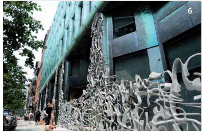
Рис. 4. Приклад художнього лиття як архітектурної прикраси: а — модель воріт; б — секції алюмінієвих виливків колажу вздовж великої будівлі Нью-Йорка
