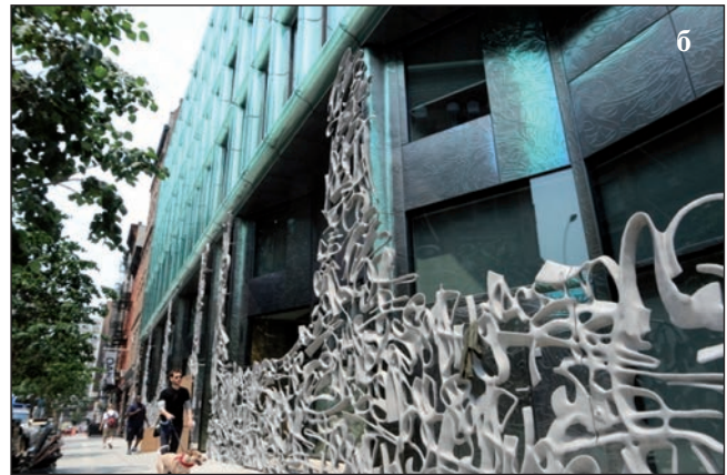
Рис. 4. Приклад художнього лиття як архітектурної прикраси: а — модель воріт; б — секції алюмінієвих виливків колажу вздовж великої будівлі Нью-Йорка
