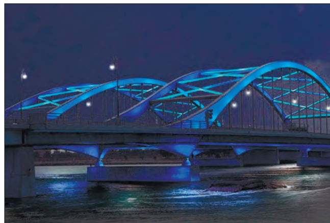
Фото 7. Міст Аль Макта зі зростанням автомобільного трафіку розширили до 4 смуг. Важливо, що при проектуванні та конструюванні мосту були враховані кліматичні особливості ОАЕ: міст розраховано на 55-градусну спеку. 2015 р., фото автора
