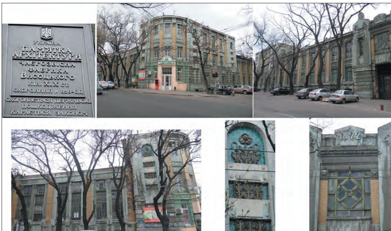
Рис. 49. Чайна фабрика Вульфа Висоцького (арх. Ц.Е. Зелинський, 1892 р., ріг вул. Троїцької, 11 і Канатної)
