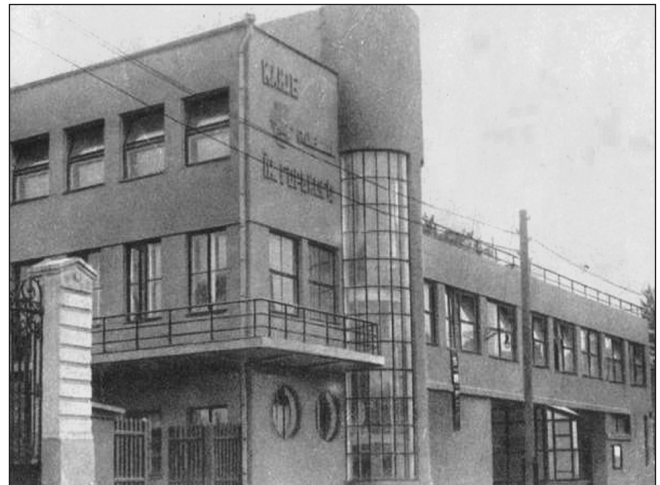
Світлина конструктивістського Клубу будівельників у Харкові (1930)
