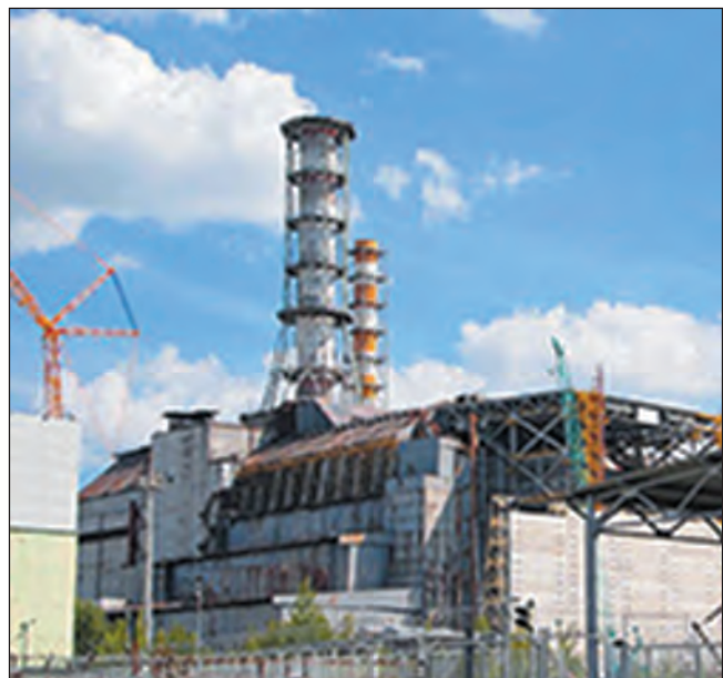
Рис. 2. Загальний вигляд збудованого об'єкта "Укриття"
