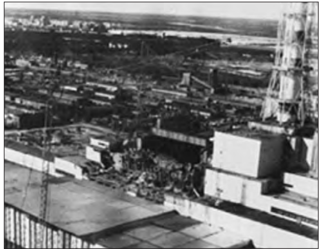
Рис. 1. Вигляд зруйнованого 4-го блоку ЧАЕС
