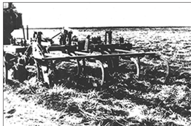
Культиватор, що підрізає коріння й залишає стерню на поверхні ґрунту
