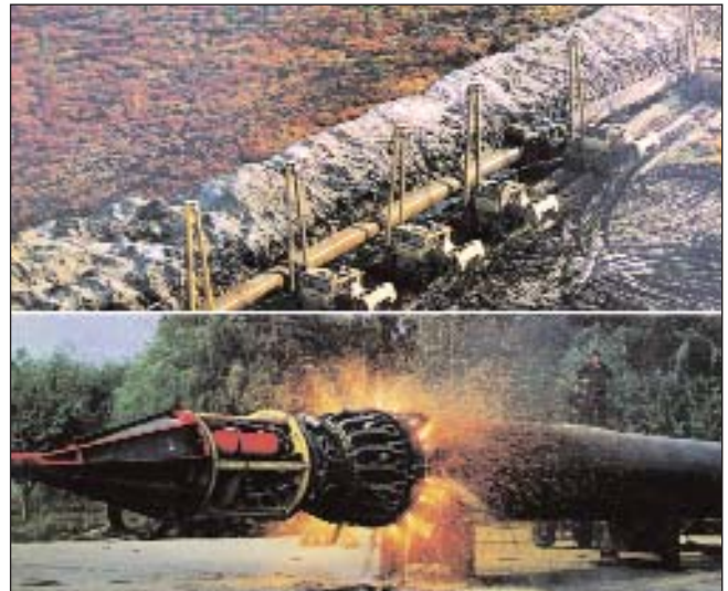
Комплекс "Север" для контактного зварювання труб магістральних трубопроводів
