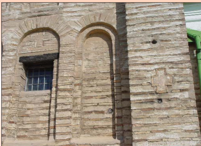
Зразок давньої кладки церкви Спаса на Берестові. Південний фасад. Позначення фундаментів зруйнованої частини церкви Спаса XII-XIII ст.
