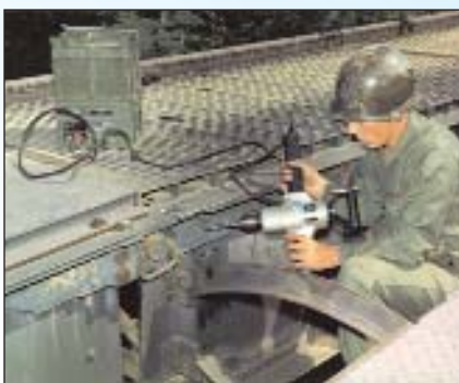
Рис. 4. Монтажні роботи з електроінструментом.
