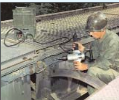
Рис. 4. Монтажні роботи з електроінструментом.
