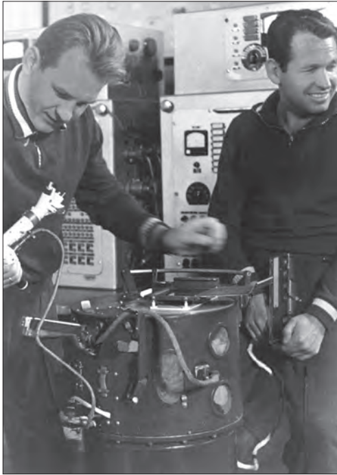
Льотчики-космонавти В. М. Кубасов і Г. С. Шонін поряд з установкою «Вулкан» для зварювання в умовах космічного вакууму і невагомості, 1968 р.
