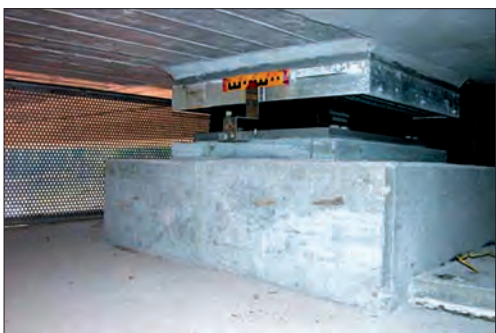
Рис. 4. Место установки резиноармированной опорной части
