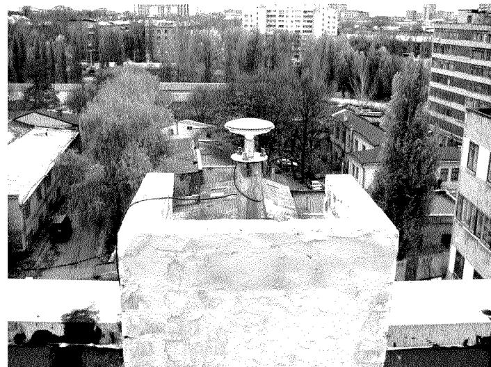
Рис. 1. Антенный пост станции SURE
