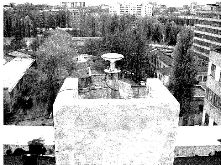
Рис. 1. Антенный пост станции SURE
