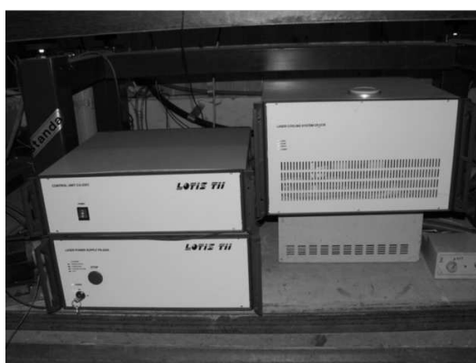
Рис. 2. Блоки живлення, охолодження та керування
